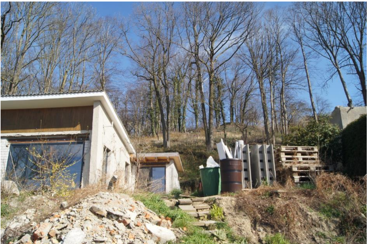
Bild 07 vorhandene Gartenhäuschen südöstlich des Plangebietes
