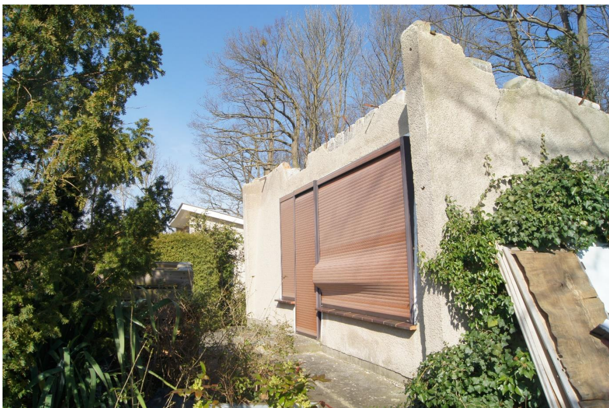
Bild 13 südliche Laube außerhalb
