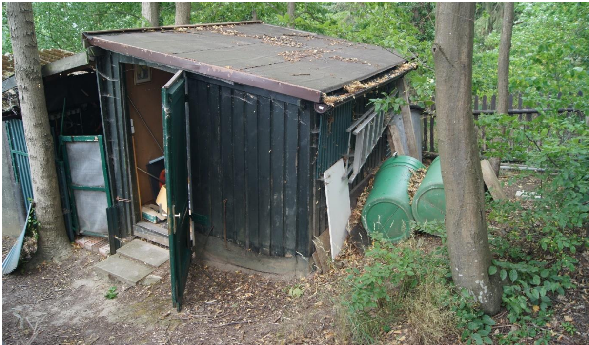
Bild 12.1 Nebengebäude zu Bild 12 in Nutzung- außerhalb
