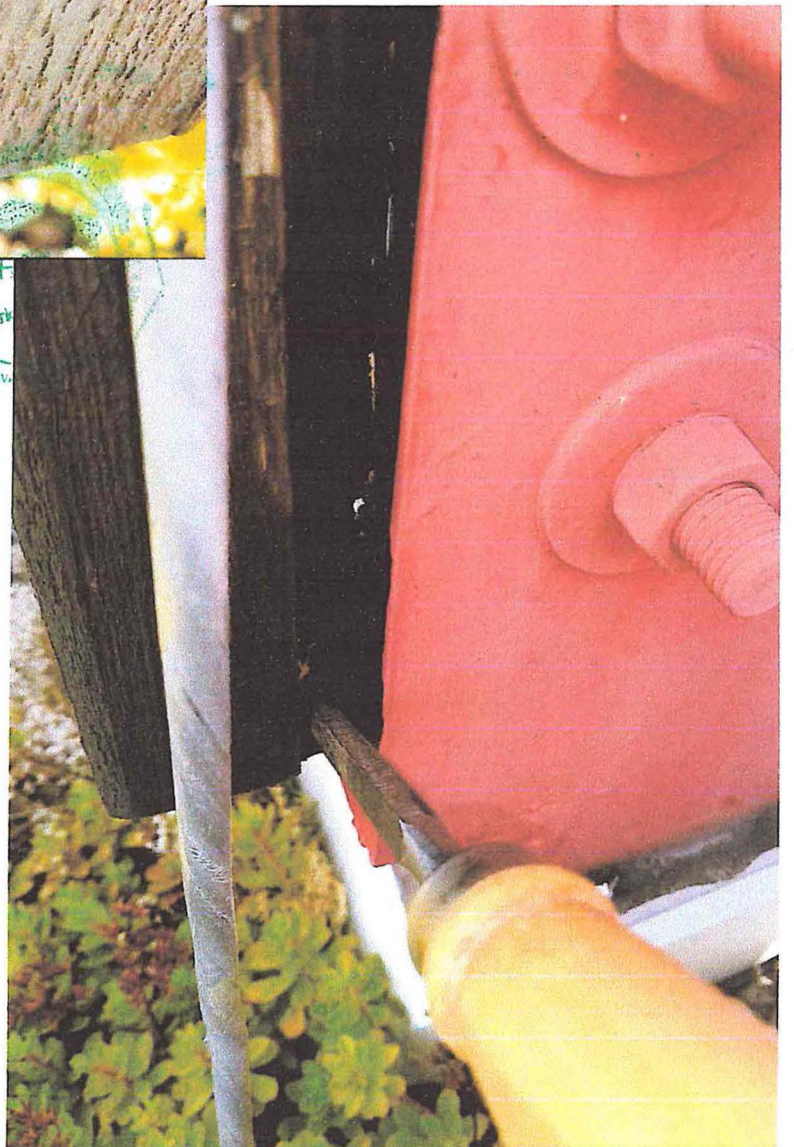
Geschädigte Stiele Südfassade Braunfäule im Auflager
