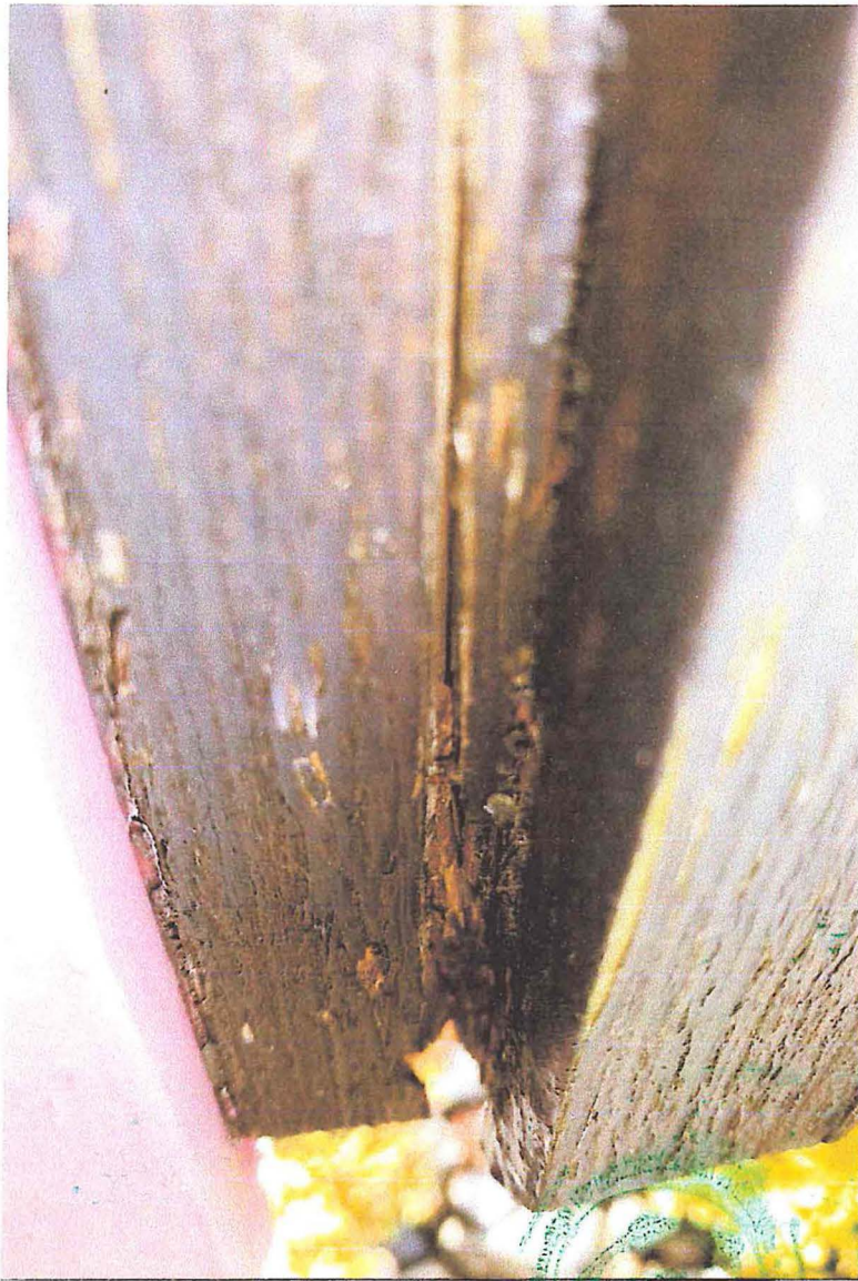
Geschädigte Stiele Südfassade Braunfäule im Auflager
