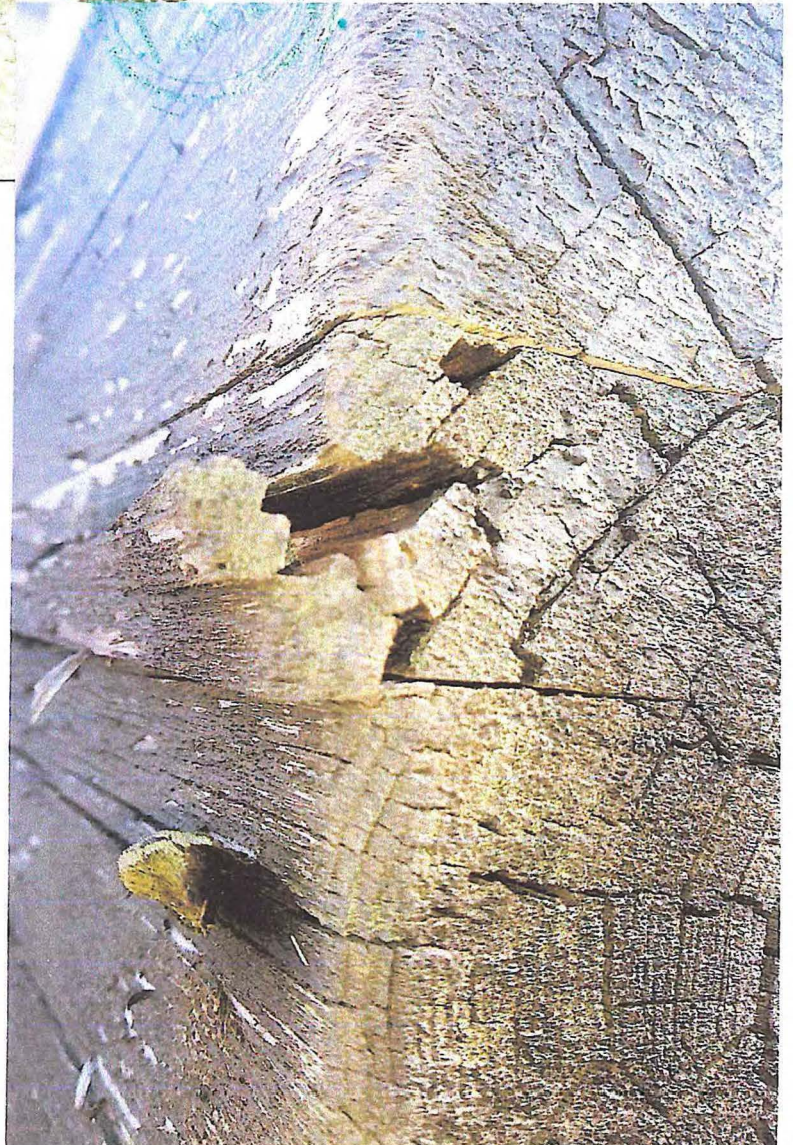
Durch Blättling (Fruchtkörper) Geschädigter DT Ausgangspunkt Hirnholz
