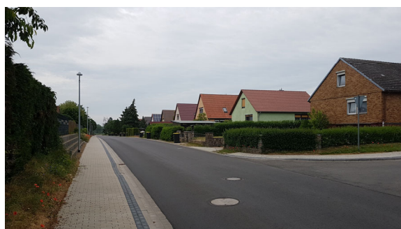
Ansicht nach dem Ausbau
