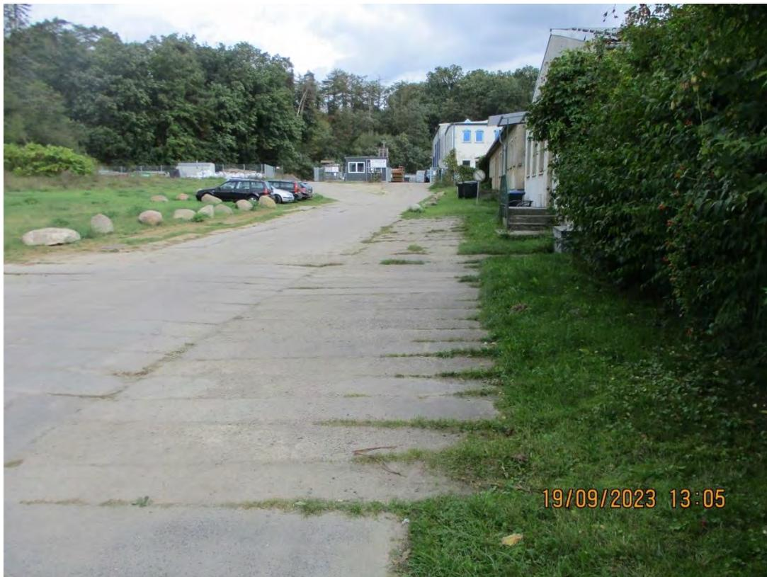
**Abbildung 6 vorh. Querschnitt Abschnitt 2 bei 0+050 mit Betonplattenstraße und ansteigendem Gelände**
