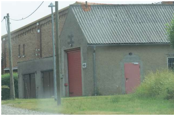
Ansicht altes Feuerwehrgerätehaus, kein Eingriff
