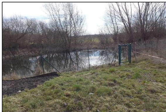
Permanentes Kleingewässer, umzäunt, als Löschwasserentnahmestelle in Nutzung
