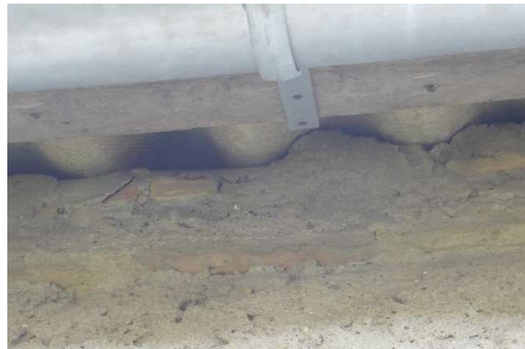
Hohlräume unter dem Dach, außerhalb GB
