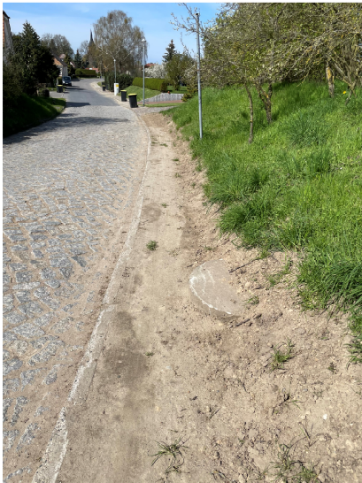
Ansicht vor dem Ausbau
