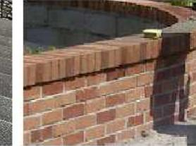
Mauern: KS verputzt + Rollschicht Klinker
