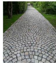
Weg aus Kleinsteinpflaster Segmentbogen-Verband
