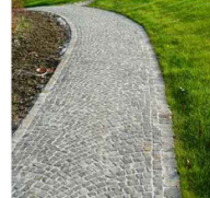
Weg aus Mosaikpflaster, Passe-Verband
