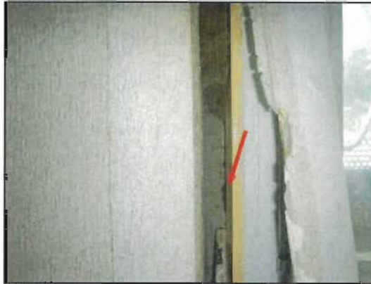
Bild 7: UG, Büro 6, Fenster, Fensterlaibung Morinol als und Mineralwollen als Dämmung in Fensterlaibungen hinter Holzzerleisten
