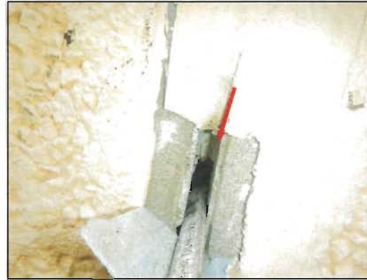
Bild 2: NE-Gebäude-Außenwand, Betonplatten-zwischenfuge (senkrecht), asbestfreie Bitumenpappen verklebt mit Styropor unterhalb von Kunststofflage
