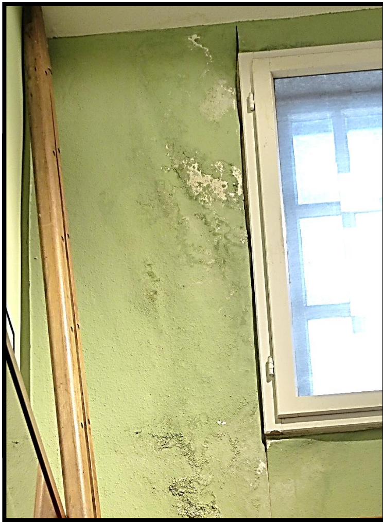
Sichtbare Wasserschäden im Treppenhaus. Mit
