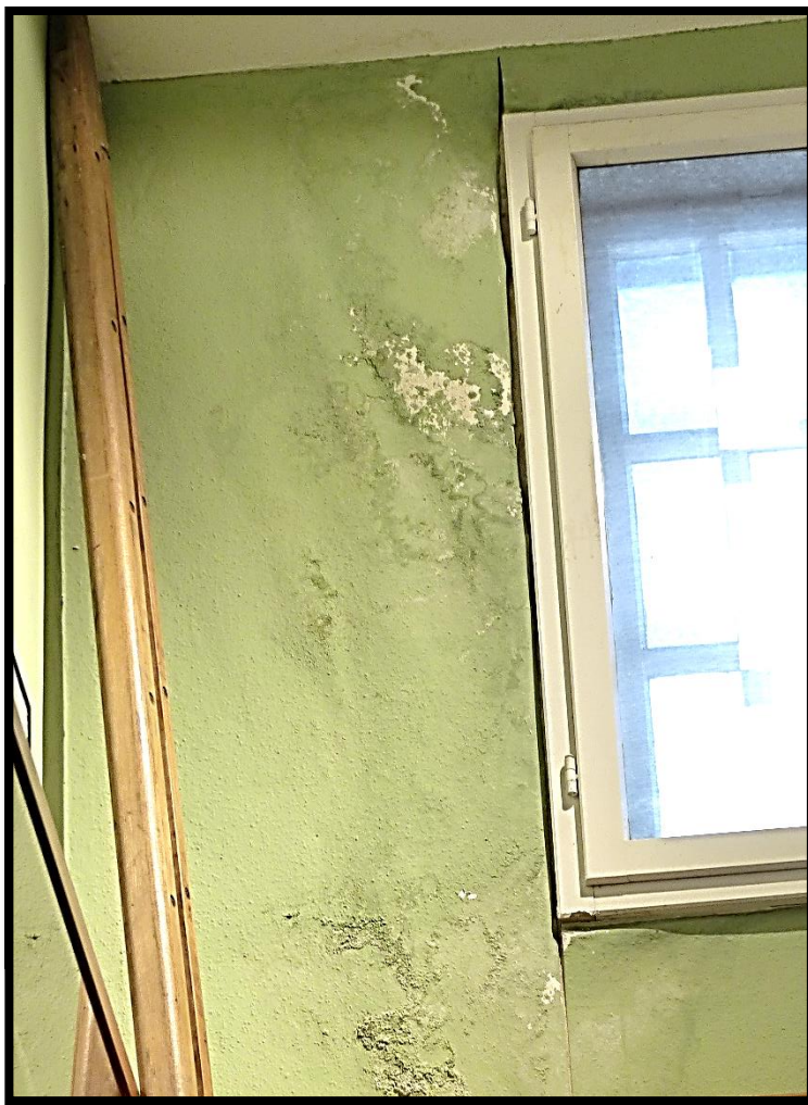
Sichtbare Wasserschäden im Treppenhaus. Mit
