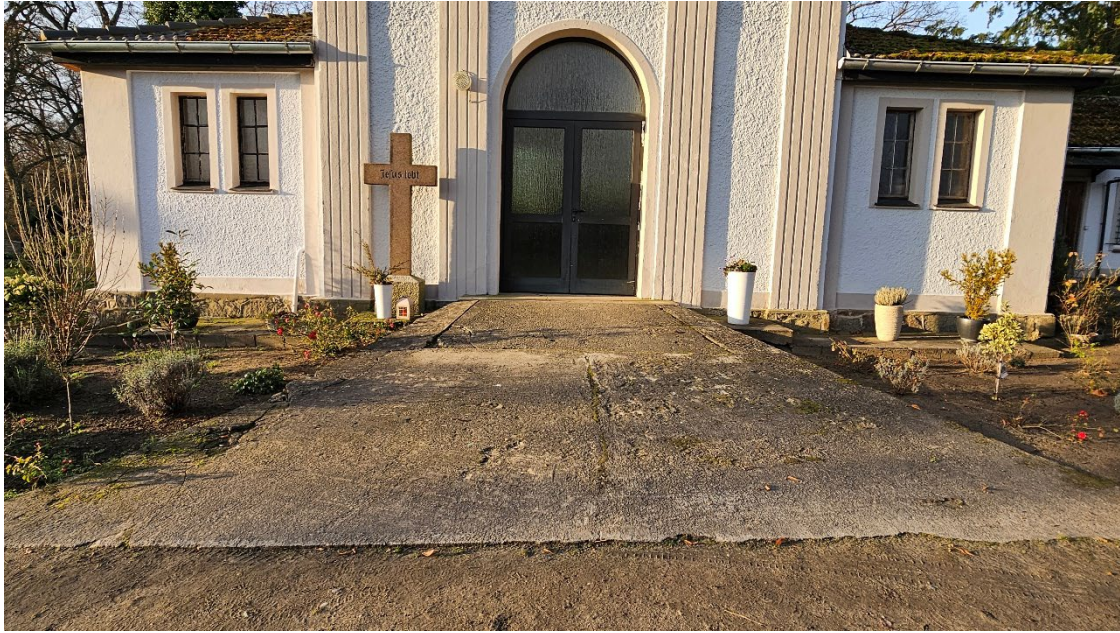
Rampe nachdem am Fußende Splitt nachgefüllt wurde
