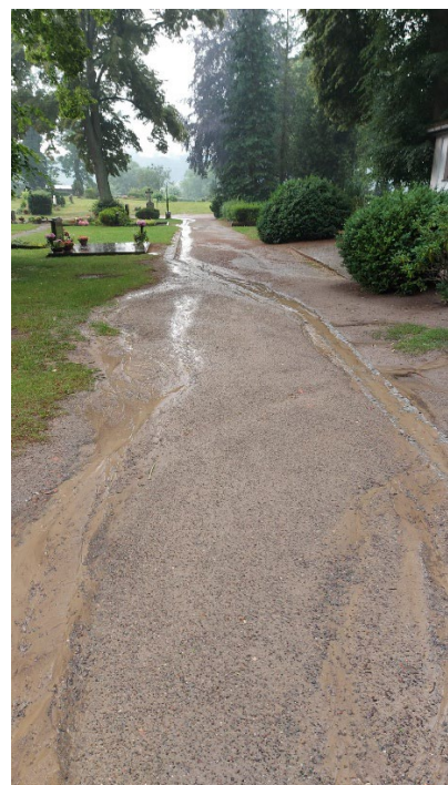
Bereich vor der Kapelle
