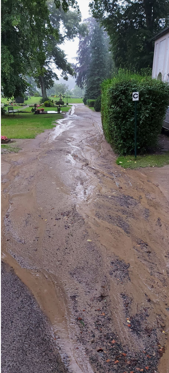
Bereich vor der Kapelle
