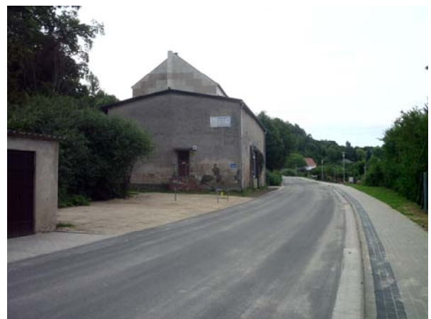
Ansicht nach dem Ausbau
