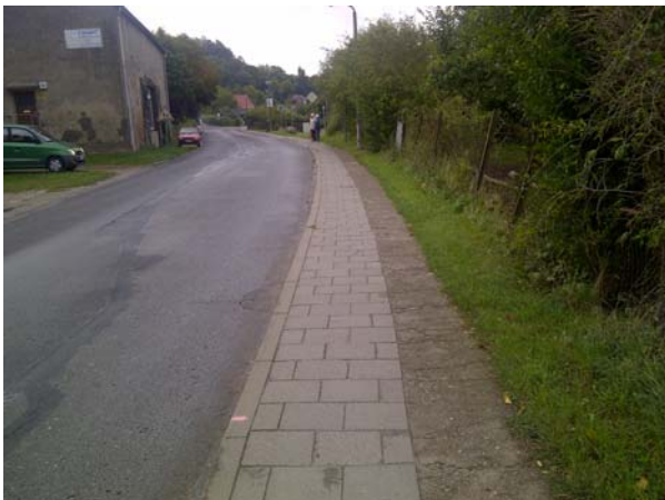
Ansicht vor dem Ausbau
