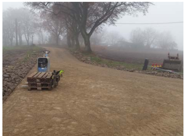
Ansicht nach dem Ausbau
