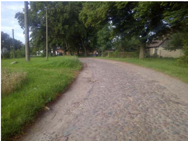
Ansicht vor dem Ausbau
