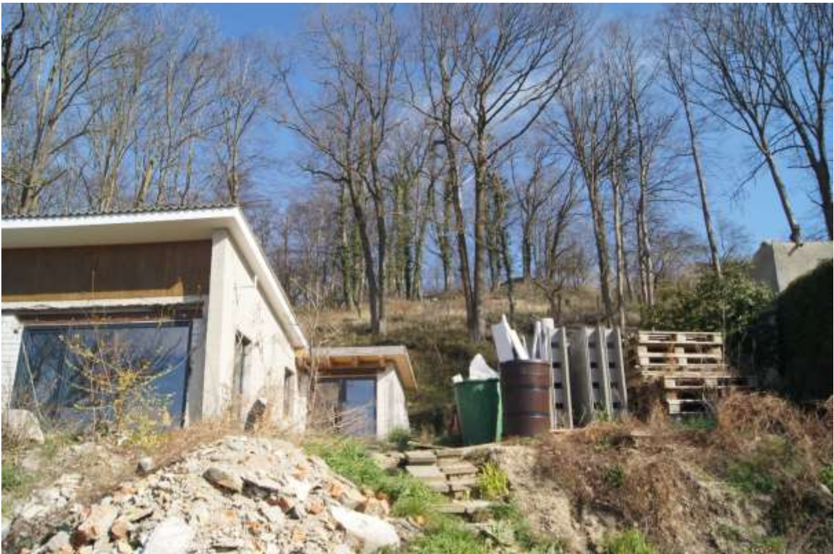
Bild 07 Im Bau befindliche Ferienhäuser im Süden der Vorhabenfläche
