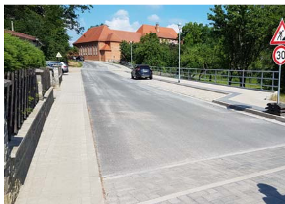
Ansicht nach dem Ausbau
