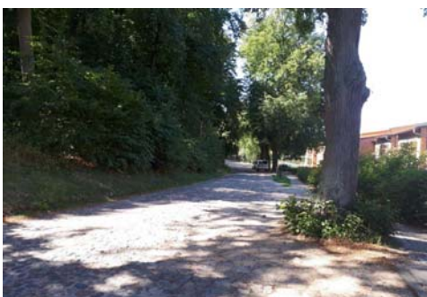
Ansicht vor dem Ausbau
