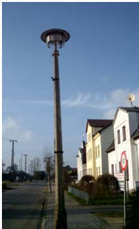
Ansicht vor dem Ausbau
