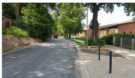
Ansicht nach dem Ausbau
