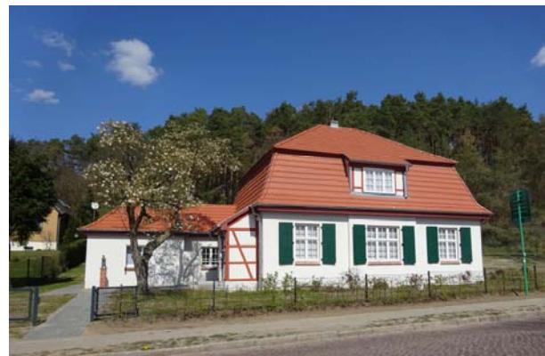
Ansicht nach dem Ausbau
