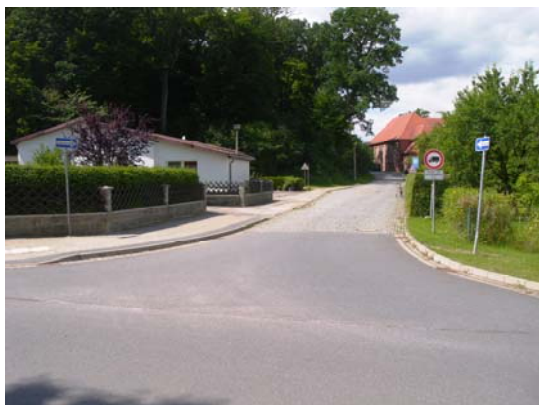
Ansicht vor dem Ausbau
