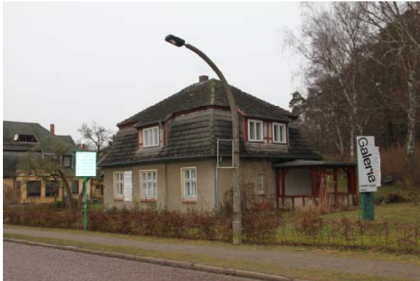
Ansicht vor dem Ausbau
