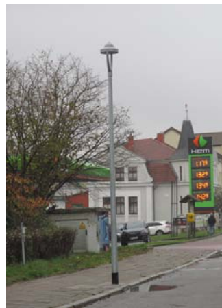
Ansicht nach dem Ausbau
