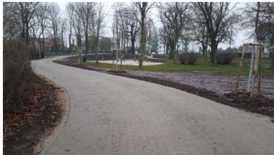
Ansicht nach dem Ausbau
