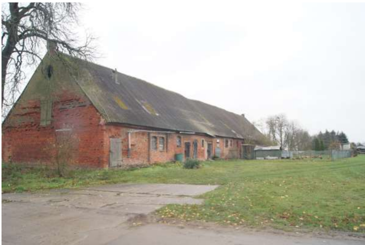
Bild 05 altes (genutztes) Stallgebäude aus Backstein mit Nutzgärten und Zierrasen
