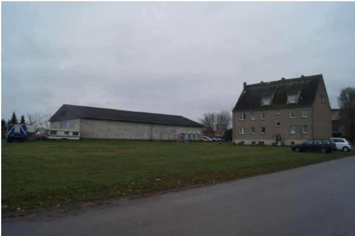
Bild 06 angrenzende Bebauung sowie betriebliche genutzte Flächen, Richtung Süden
